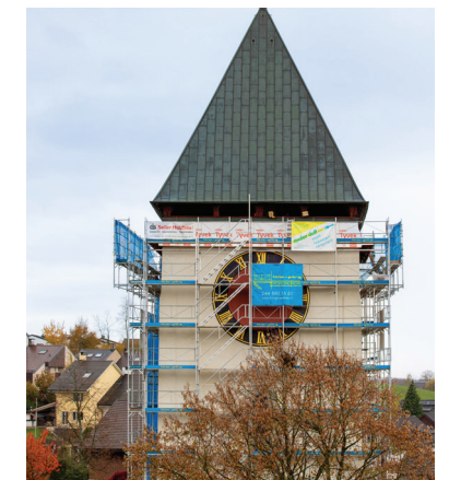
Der Kirchturm Illnau wird saniert
