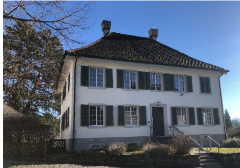
Pfarrhaus Kyburg mit neuen Fenstern
