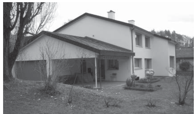
Das Pfarrhaus Erlenstrasse nach der Rundumerneuerung
